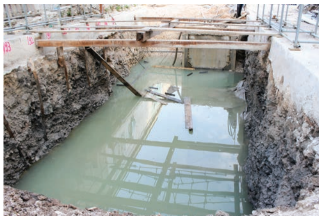
Sl. 4 Nalazište prije osiguravanja konstantne odvodnje fekalnih i oborinskih voda (foto: M. Čuka).
