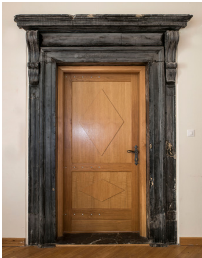
15. Portal od crnog mramora u sjeverozapadnoj prostoriji prvog kata (snimila N. Vasić, HRZ, 2017.)
