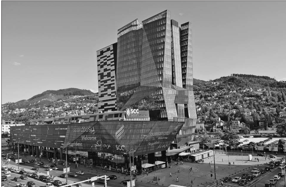
FIG. 7 INTIMIDATING MASSES OF CONTEMPORARY ARCHITECTURE SL. 7. ZASTRAŠUJUĆI RAZMJERI SUVREMENE ARHITEKTURE
