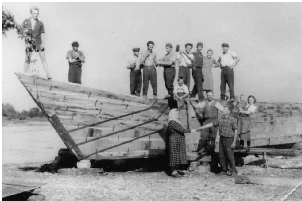
Slika 22. Izgradnja kompe za potrebe postavljanja vodenice kod Novog Virja 1950-ih godina (arhiv Z. Ištvana)
