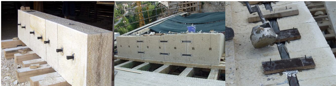
Slika 2. Detalji sklapanja svoda mosta
