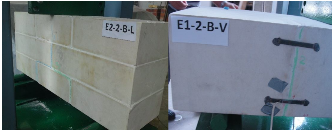
Slika 9. Pojava prvih pukotina u sljubnicama morta
