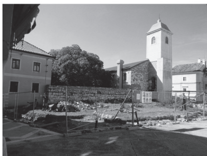
Sl. 29. Čelična zaštitna ograda – zaštita lokaliteta
