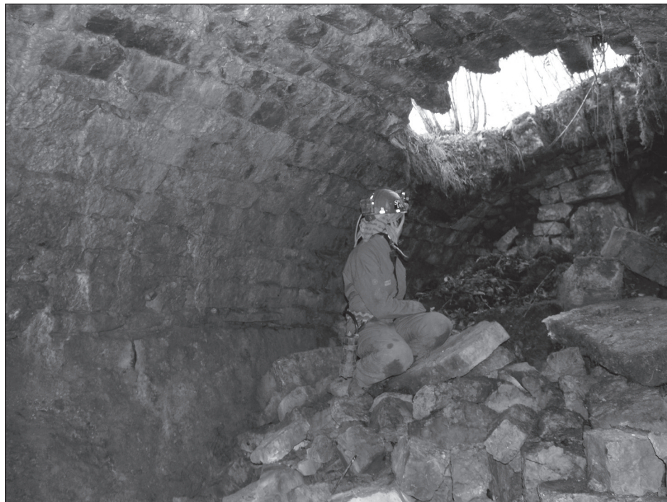
Sl. 5. Unutrašnjost Cisterne na gradini Bužim - donji dio ukopan u živoj stijeni, foto: Vlado Božić, 2009.
