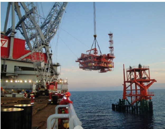
Slika 8. Oleg Strashnov tijekom instaliranja procesnog dijela platforme Ika JZ
