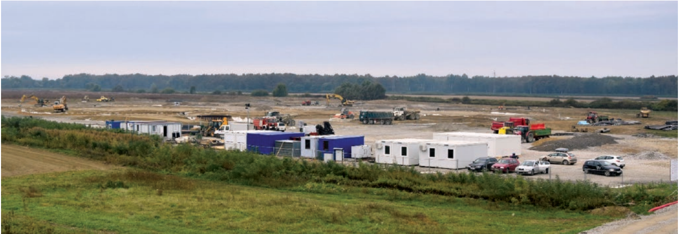
Slika 4. Gradilište kompresorske stanice
