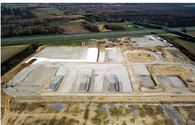
Slika 6. Izrada nasipa za predopterećenje
