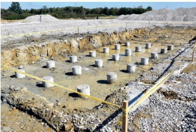
Slika 5. Ugradnja armiranobetonskih pilota ispod temelja kompresorske stanice
