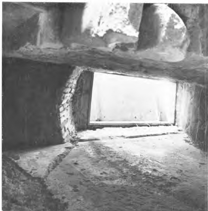
59. MILJANA, dvorac, tavanско stubište pročeljnog krila
