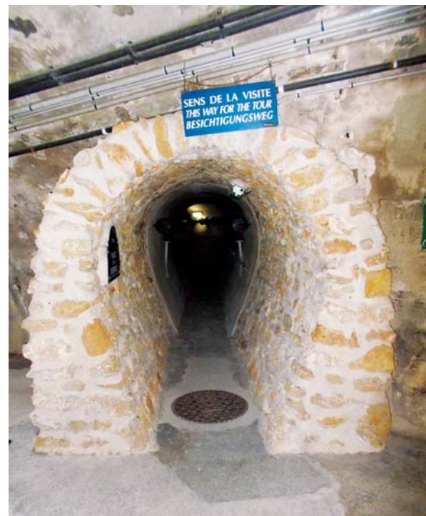
Slika 8: Tipičan jajoliki presjek kanala kao dio Muzeja kanalizacije (fotografirao: Josip Rubeša).
