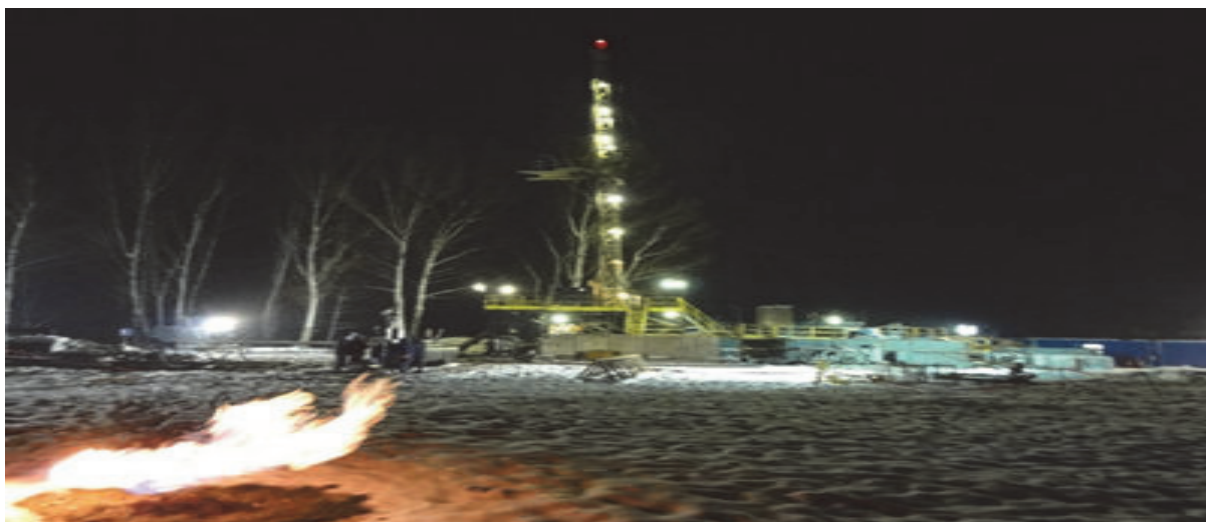
Slika 6. Hidrodinamsko ispitivanje na lokaciji buduće geotermalne-elektreane Draškovec
