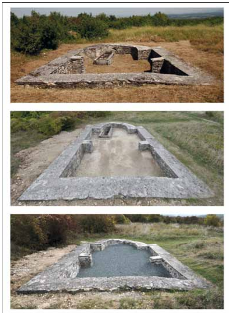
Slika 15. Pogled sa zapada na rudinsku grobljansku kapelu prije, tijekom i nakon prve faze konzervatorsko-restauratorskih građevinskih radova. Snimke: T. Pleše, 2015. (arhiva HRZ-a)
