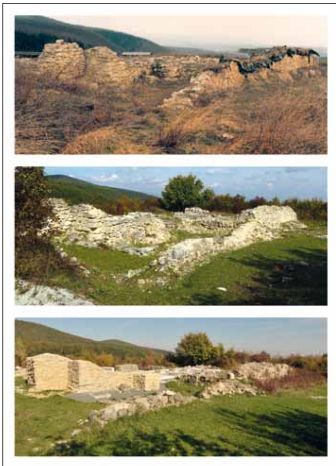
Slika 16. Pogled s jugozapada na rudinsku opatiju prije, tijekom i nakon prve faze konzervatorsko-restauratorskih građevinskih radova. GMP, 1992. (arhiva GMP-a) i T. Pleše, 2013. i 2017. (arhiva HRZ-a)
