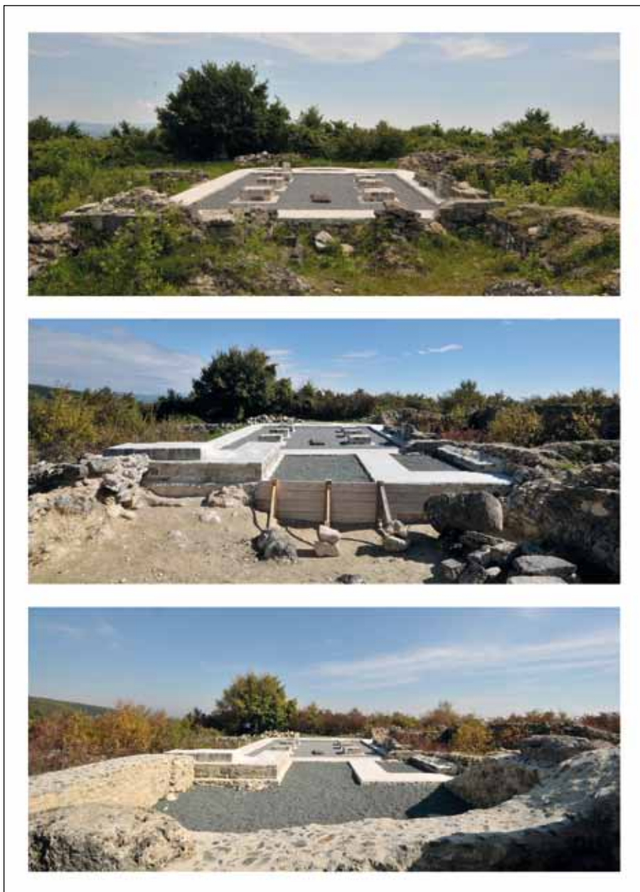
Slika 13. Pogled sa zapada na rudinsku opatijsku crkvu tijekom i nakon prve faze konzervatorsko-restauratorskih građevinskih radova. Snimke: T. Pleše, 2015., 2016. i 2017. (arhiva HRZ-a)
