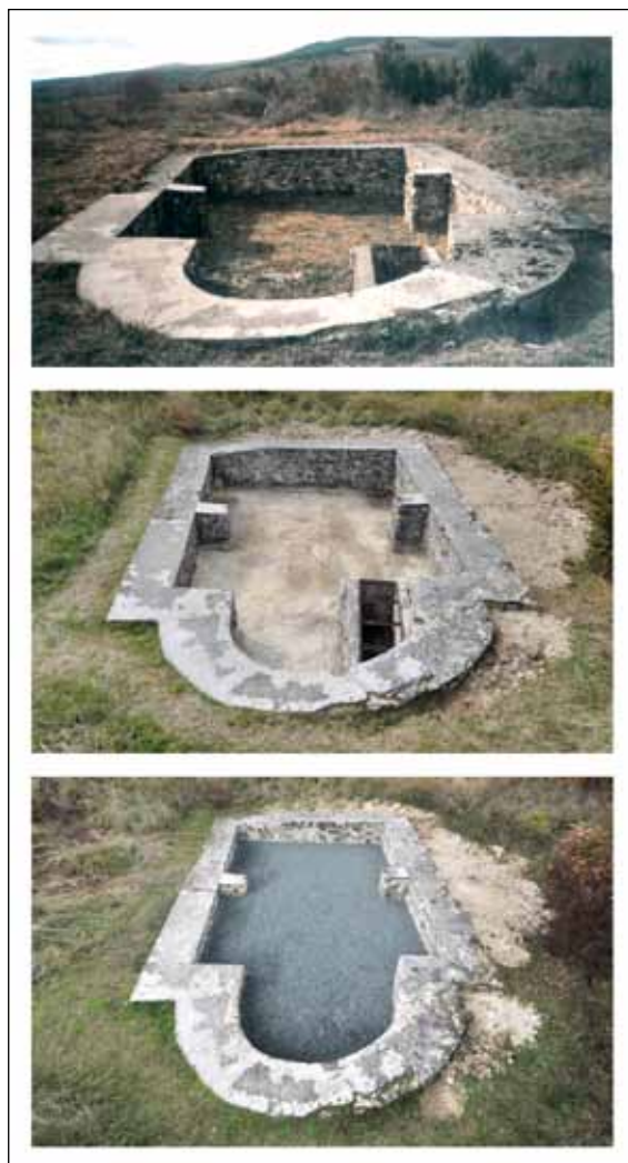
Slika 14. Pogled s istoka na rudinsku grobljansku kapelu prije, tijekom i nakon prve faze konzervatorsko-restauratorskih građevinskih radova. Snimke: GMP, 2004. (arhiva GMP-a) i T. Pleše, 2015. (arhiva HRZ-a)
