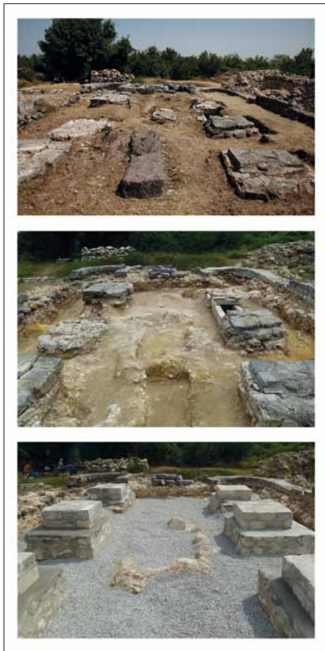
Slika 12. Pogled sa zapada na rudinsku opatijsku crkvu prije i tijekom prve faze konzervator-sko-restauratorskih građevinskih radova. Snimke: T. Pleše, 2013. i 2014. (arhiva HRZ-a)
