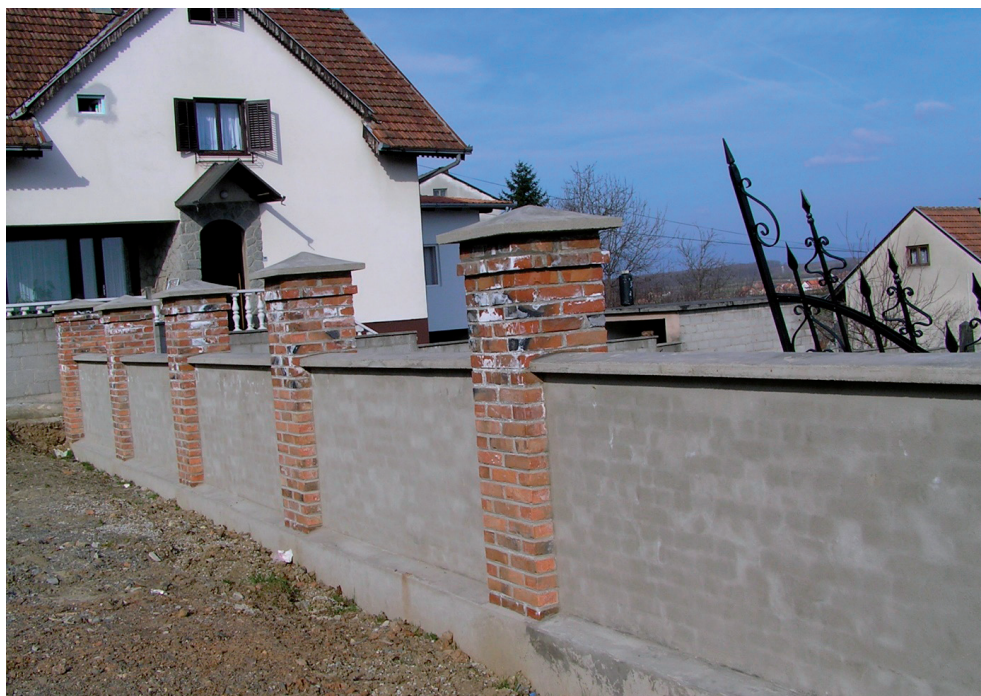
Rekonstrukcija zida na južnoj strani židovskoga groblja (fototeka KO Požega)
