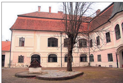
4. Začetna strana zapadnog krila dvorca
