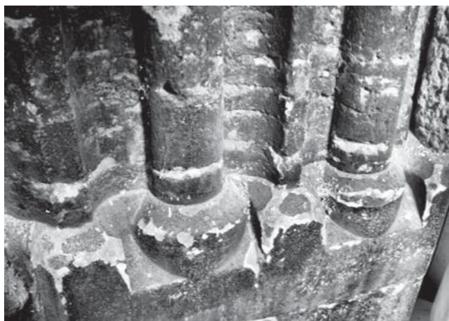
Arhitektura Južnog portala svetog Marka, baze, stanje 2004., foto ZB.
