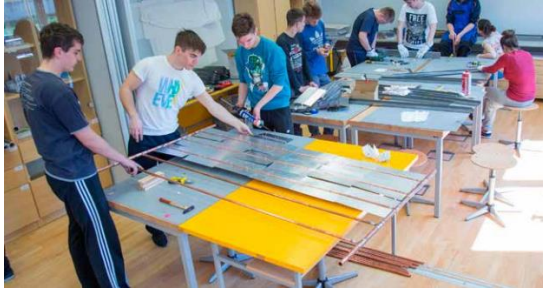
Slika 3. Izrada bakrene rešetke i okvira
