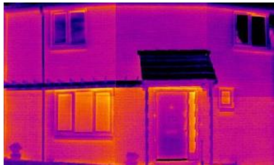
Slika 16. Toplinska postojanost betonske kuće (OldBuilders Company, 2016)
