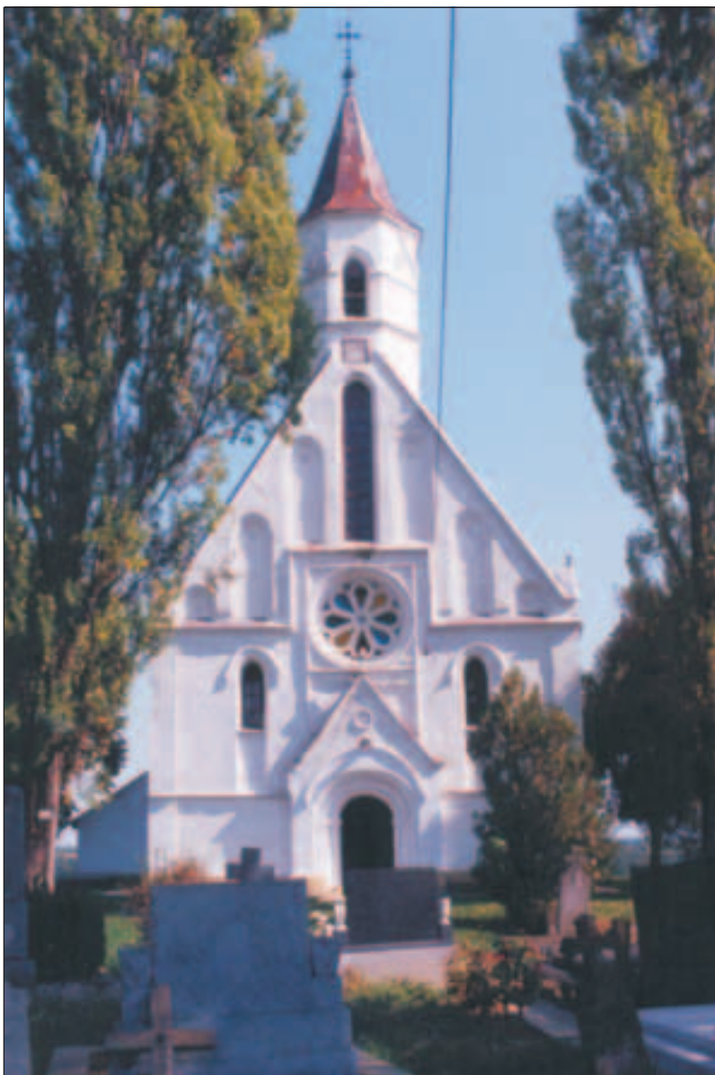
Glavno pročelje (pogled sa zapada)
