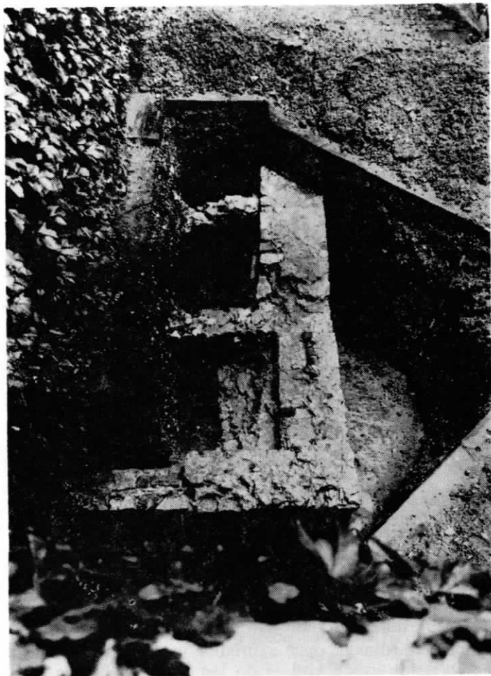
Sl. 3. Ostaci srednjovjekovne arhitekture u dvorištu Starog grada (Foto: B. Vikić) Mittelalterliche Baureste im Hof der alten Burg (Foto: B. Vikić)
