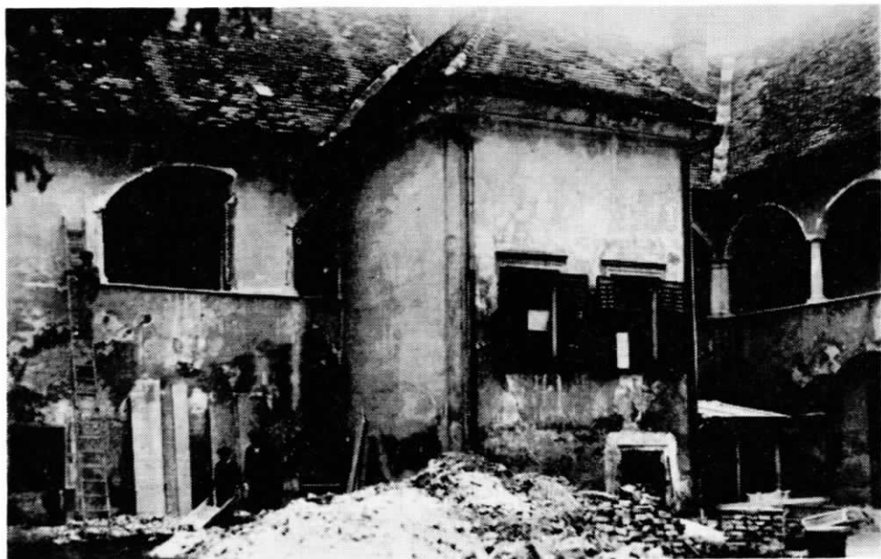
Sl. 7. Dvorišno pročelje palače Sermage Das Palast der Familie Sermage, Hofansicht
