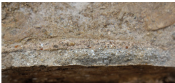
7. Presjek žbuknog sloja (snimila A. Požar Piplica) Plaster layer cross-section (A. Požar Piplica)
