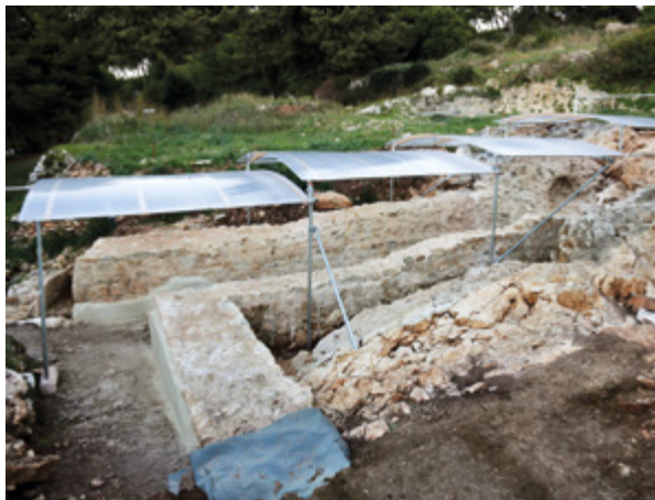
13. Zaštitna sjenica (snimio L. Piplica) Protective pavilion (L. Piplica)
