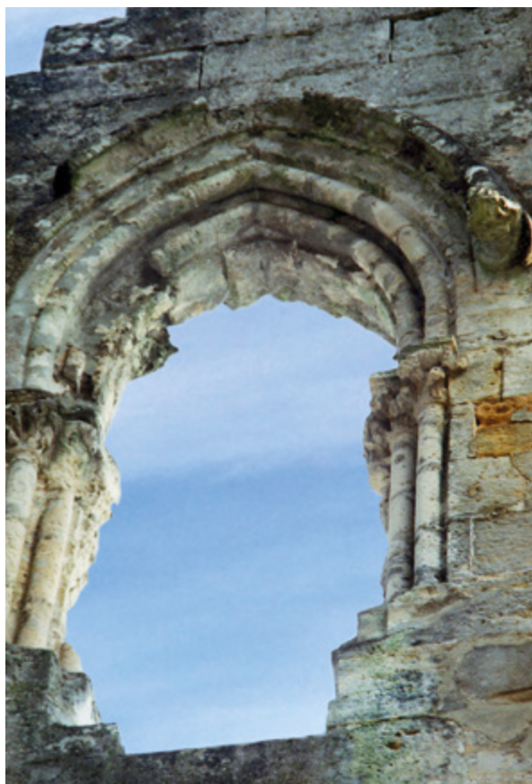
7. Profilacije i kapiteli manjeg prozora portala (snimio D. Miletić) Profiling and capitals of a smaller window on the portal (D. Miletić)
