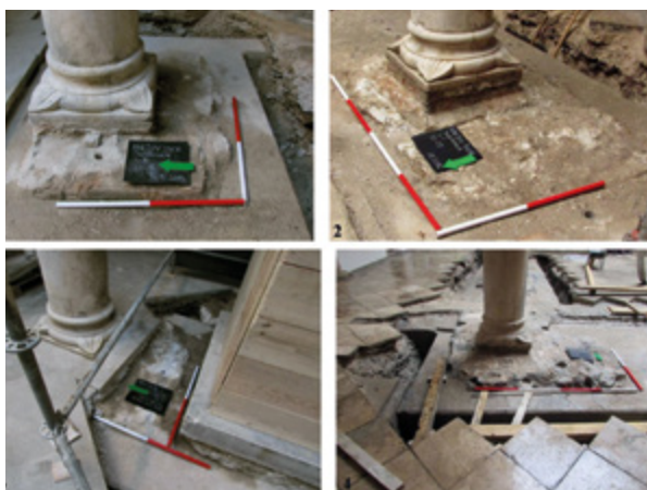
9. Temelji stupova u atriju Dvora (Dokumentacija o arheološkom nadzoru, Zavod za obnovu Dubrovnika, snimila N. Topić, 2015. – 2016.)
