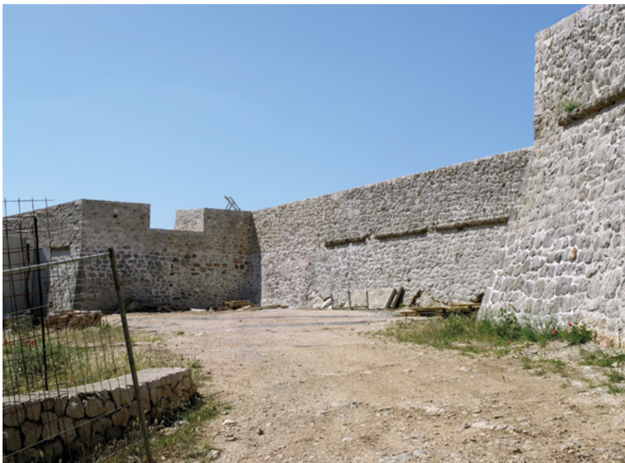
10. Ostaci kordonskog vijenca na bedemu i polubastionima (snimio I. Glavaš, 2015.) Remains of cordon cornice on the bulwark and half-bastions (I. Glavaš, 2015)
