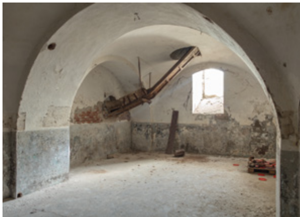
Sl. 13. Prostorna jedinica prizemlja s drvenom rampom za spuštanje sirovina (fototeka HRZ-a, snimio G. Tomljenović) Ground-floor unit with a wooden ramp to lower raw material (Croatian Conservation Institute Photo Archives, G. Tomljenović)
