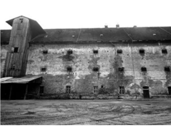
Sl. 6. Sjeverno pročelje s teretnim dizalom i natkrivenom upravljačkom jedinicom (Državni arhiv u Osijeku, 1972./1973.) North façade with cargo elevator and covered control unit (State Archives in Osijek, 1972/1973)
