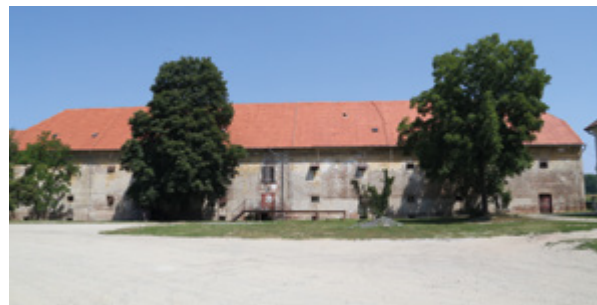
Sl. 2. Pogled na južno pročelje zgrade vojne pekare i skladišta (fototeka Konzervatorskog odjela u Osijeku, snimila A. Mutnjaković)
