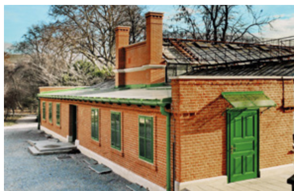
11. Staklenici sa sjeveroistoka 2018. (snimio M. Perušić) Greenhouses view from the north-east, 2018 (M. Perušić)
