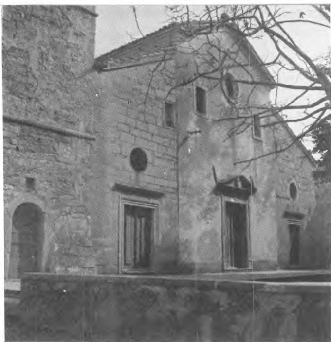
4. Roč, sv. Bartul — zapadna fasada sa tornjem
