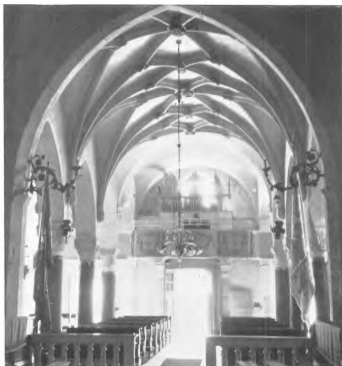
8. Unutrašnjost prema zapadu
