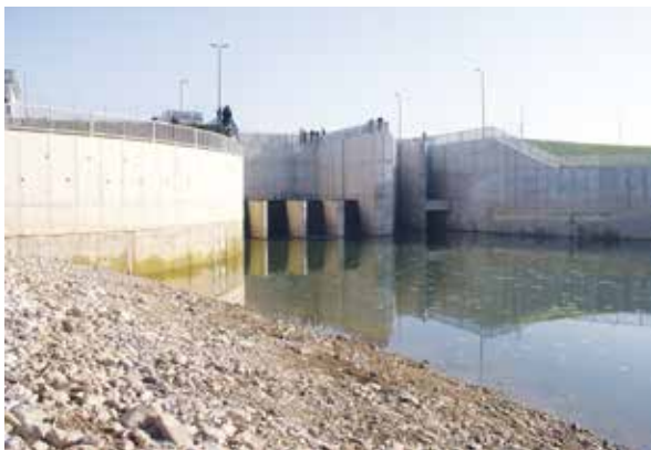
Upusna građevina na dovodnom kanalu Biđ-polja, 8. prosinca 2016. (foto: M. Bagarić)
