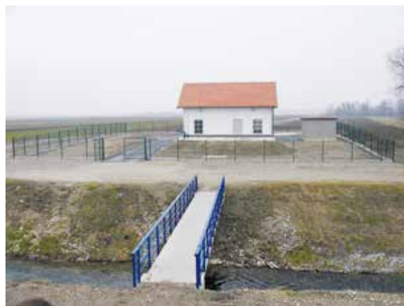
Crpna stanica sustava navodnjavanja Međimurje (foto: M. Bagarić)
