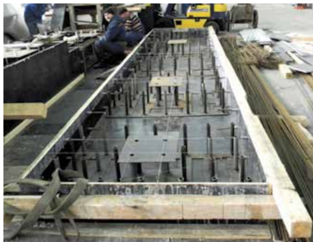
Slika 8. Izrada AB kontinuirane ploče koja predstavlja rasponsku konstrukciju mosta
