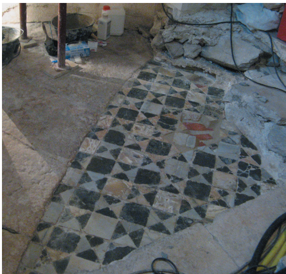
Kameno popločenje i mramorni pločnik (opus sectile) otkriven prilikom obnove kapele sv. Staša 2015. godine
