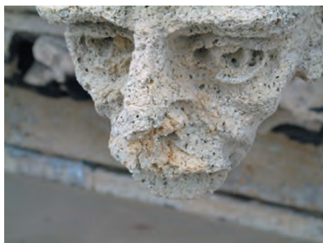
Detalj glave rigalice na II. galeriji sjevernog tornja
