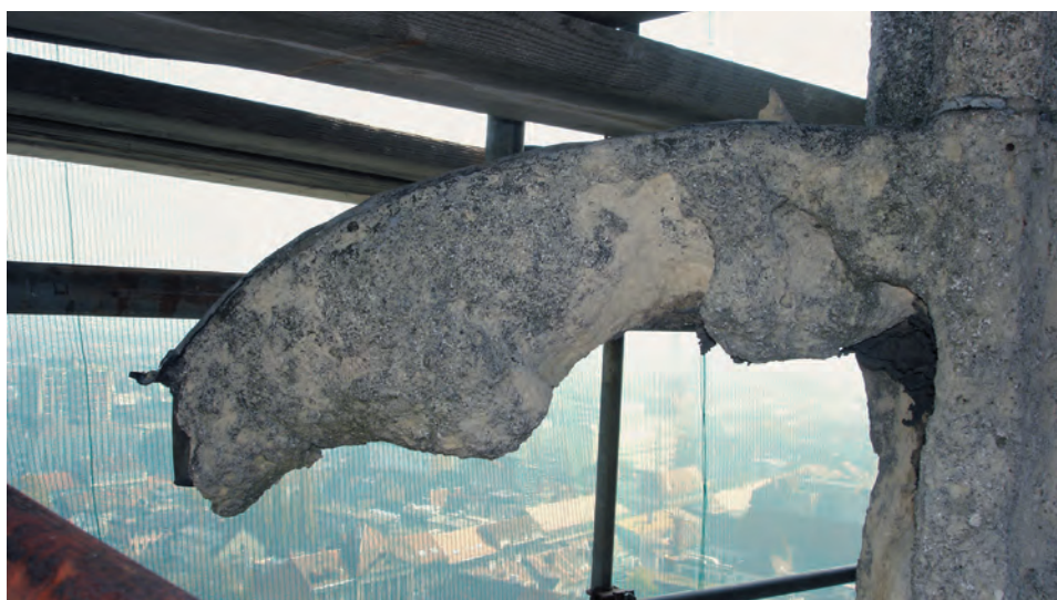
Rigalica iznad II. galerije sjevernog tornja
