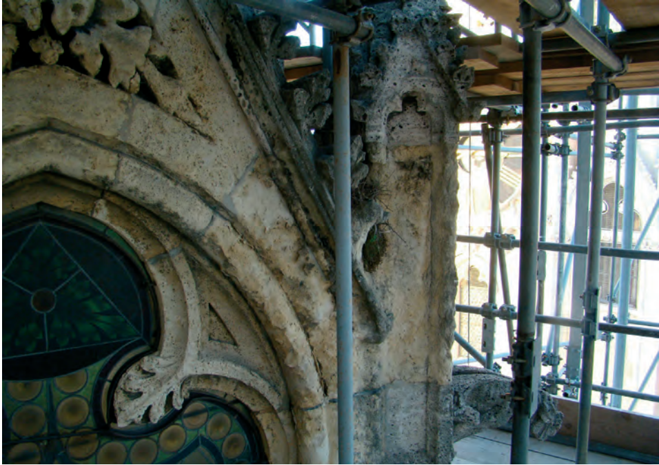
Oštećenja baldahina II. galerije južnoga tornja na kojemu je vidljiva obnova 1938. – 1940. (foto: D. Foretić)
