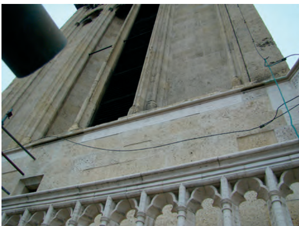
Izgled zida iznad I. galerije nakon obnove
