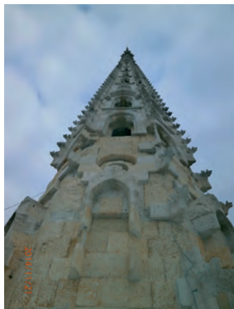
Južni zvonik nakon demontaže kamenih elemenata koji su bili predviđeni projektom – vide se mjesta za tašele
