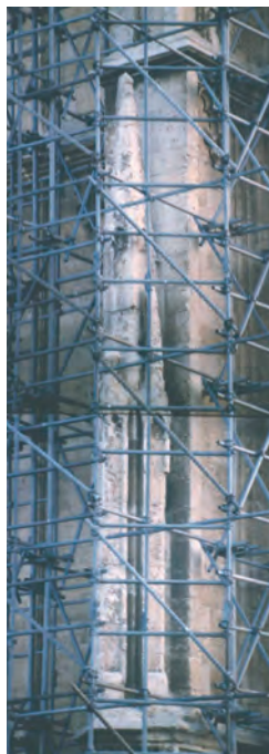
Sjeverni kontrafori zvonika prije obnove
