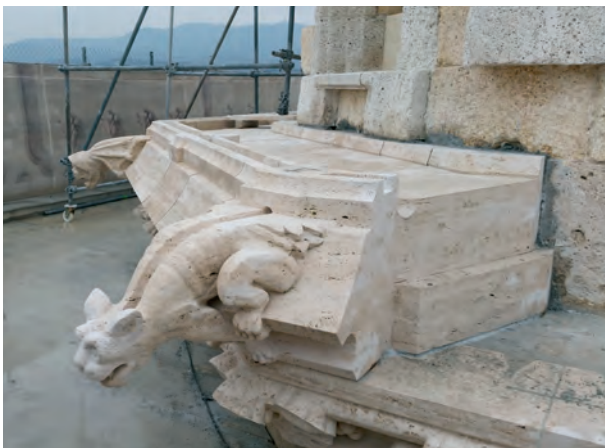
Podnožje III. galerije južnog zvonika u obnovi (klesarski rad radionice Kamen Pučišća d.o.o.)
