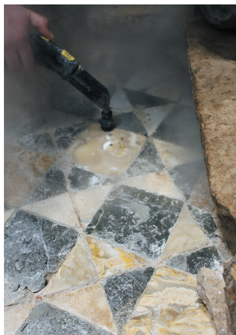
Mokro čišćenje mozaika parnim čistačem
