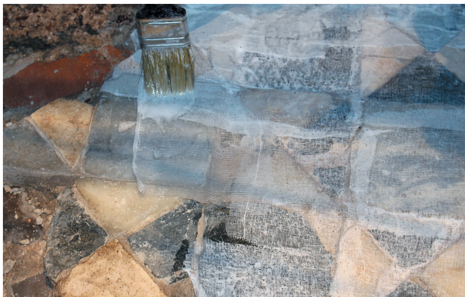
Preventivna zaštita mozaika postavljanjem slojeva gaze namočenih u Vinavil
