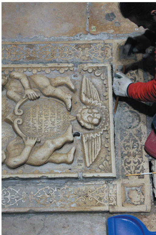
Čišćenje sljubnica na grobnici Capogrosso
