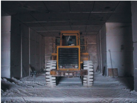
c) vađenje "oslobođenih" blokova
