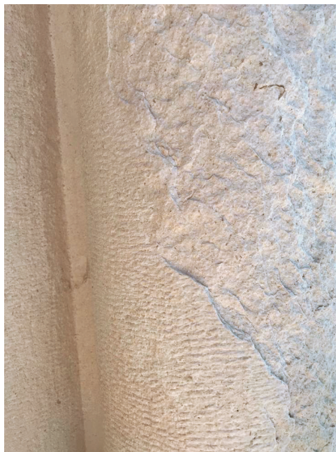
Primjer degradacije kamena kasnije ugrađenoga – uvećano
