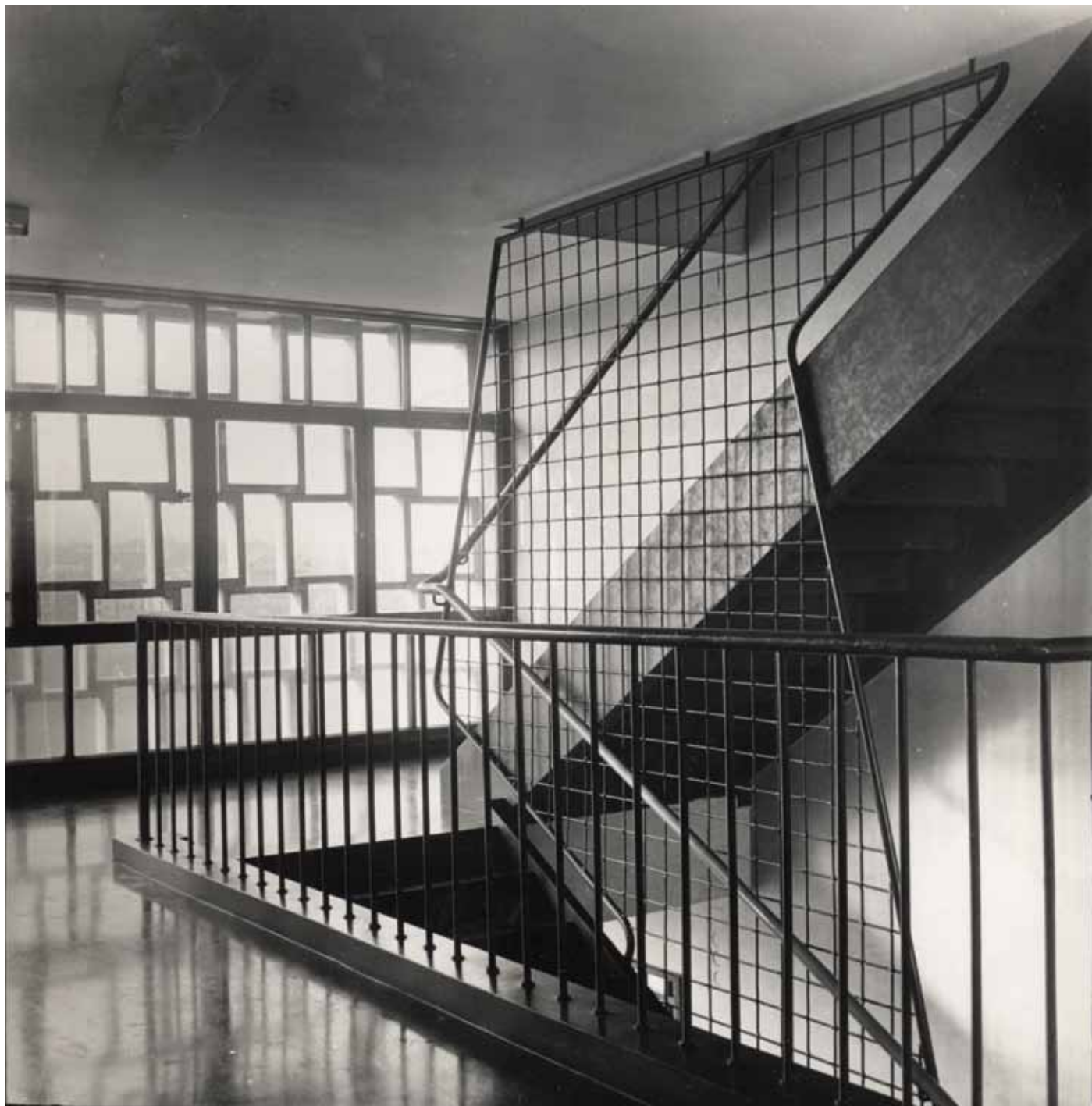
Drago Galić, Stambena zgrada vojne oblasti Zagreb (danas Ulica grada Vukovara 35-35a i 43-43a, Zagreb), 1954., fotografija, fotograf: Ante Roca
