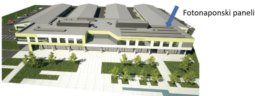
Slika 1 Razvojni centar i tehnološki park u Križevcima s fotonaponskom elektranom
