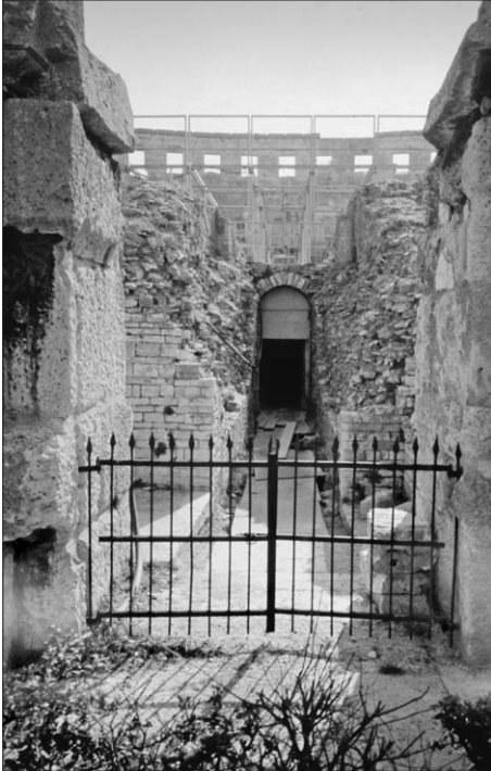
SL. 8. SAČUVANI IZVORNI OSTATCI SREDIŠNJEGA KANALIZACIJSKOG KOLEKTORA (18-19) PRIJE PROVEDENE REKONSTRUKCIJE 1986.
