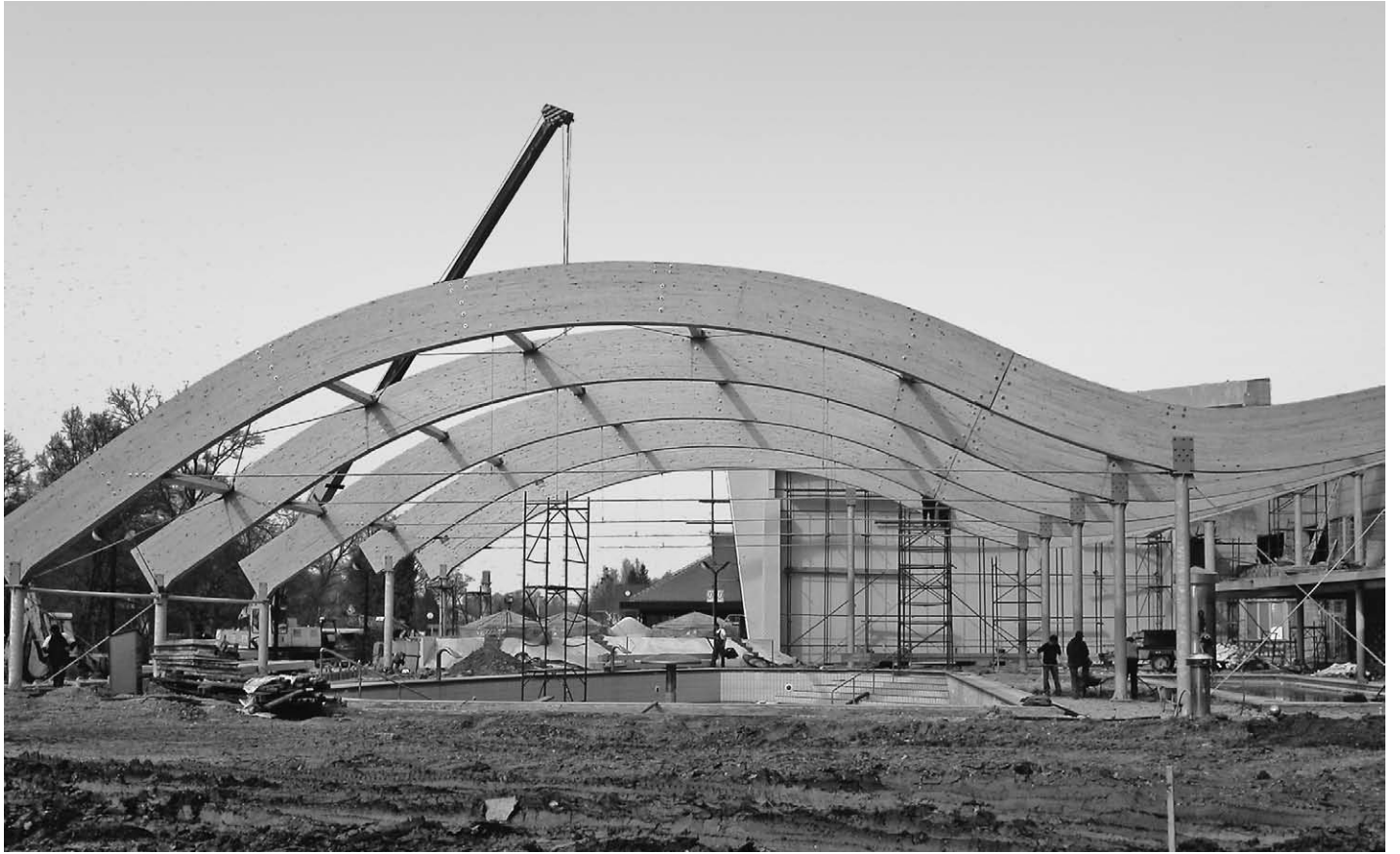
SL. 1. PRIKAZ LAMELIRANIH NOSAČA KROVNE KONSTRUKCIJE U Sv. MARTINU NA MURI U FAZI MONTAŽE. VIDLJIVE SU ZATEGE ZBOG KOJIH JE POSTIGNUTA UŠTEDA U VISINI POPREČNOG PRESJEKA NOSAČA. ARHITEKT: V. PEDIŠIĆ, AUTORI KONSTRUKCIJE: M. HAIMAN I B. BALJKAS, GODINA IZGRADNJE: 2005. FIG. 1 GLULAM ROOF STRUCTURE GIRDERS IN Sv. MARTIN NA MURI [ST. MARTIN ON THE MURA], IN THE ASSEMBLY PHASE. TIE RODS THAT ALLOW THE REDUCTION AT THE HEIGHT OF THE GIRDERS' CROSS-SECTION, ARE VISIBLE. ARCHITECT: V. PEDIŠIĆ, THE STRUCTURE DESIGNED BY: M. HAIMAN AND B. BALJKAS, YEAR OF CONSTRUCTION: 2005
