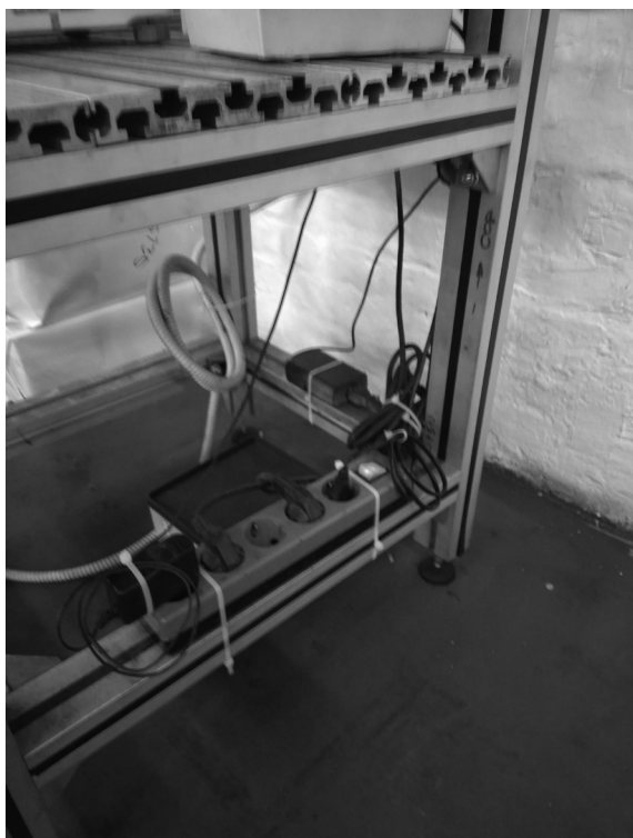
Slika 2. Instalacije nakon otklanjanja nedostataka
