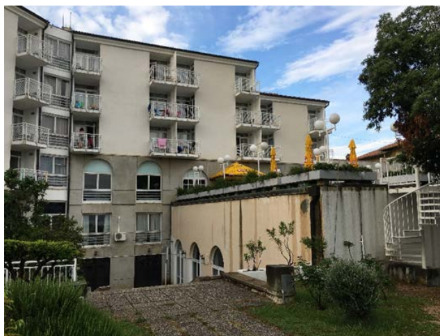
Slika 6. Dograđena zgrada „B“ prije posljednje rekonstrukcije 2018. godine. Autor.
