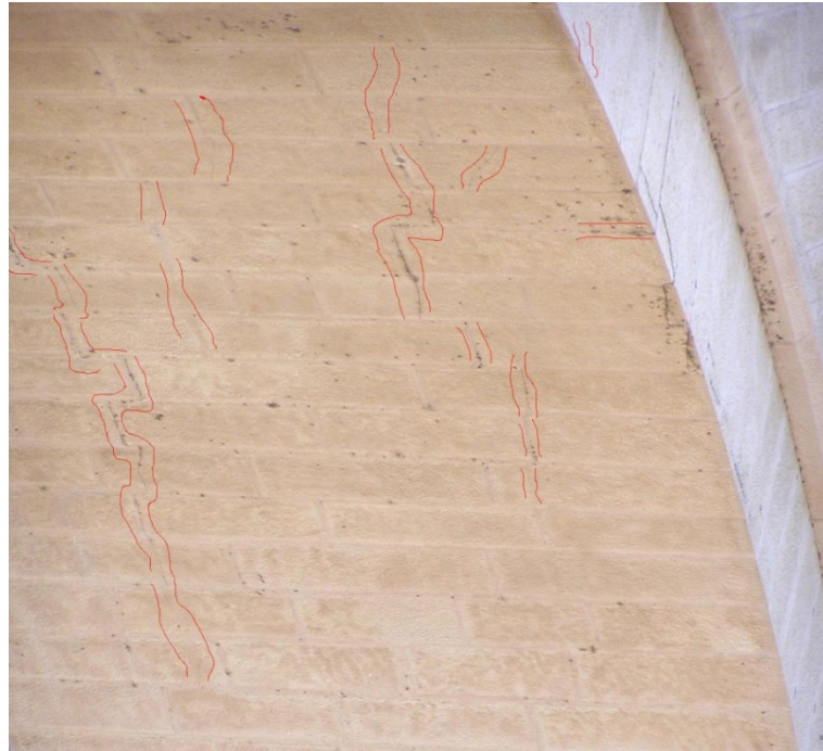
Slika 2. Naprsline na intradosu mosta 9.11.2008. godine
