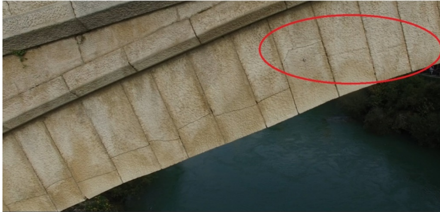
Slika 9. Naprsline nizvodna strana luka iz 2013. i 2018. godine. Vidljive nove naprsline desno od repera
