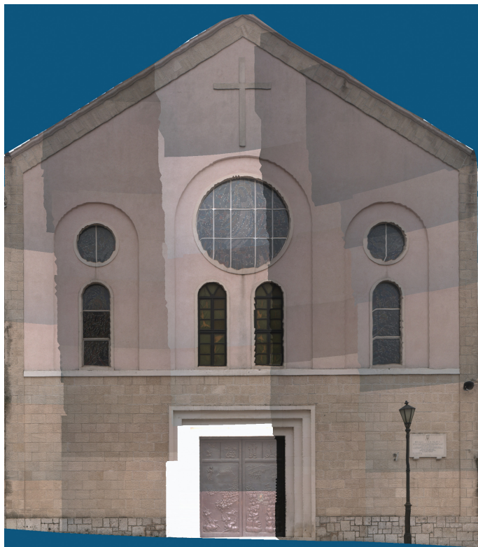
Slika 4-9. Ortofoto dijela pročelja
