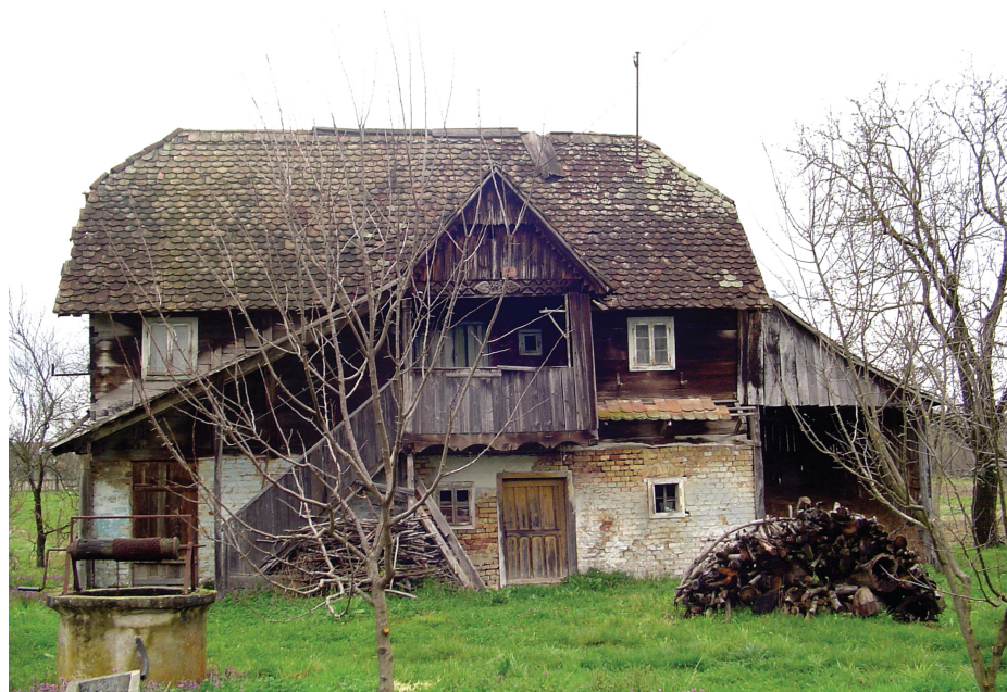
Slika 1-1. Autohtona građevina (drvena korablja) s područja Sisačko-moslavačke županije izgrađena prije 15. veljače 1968. god.
