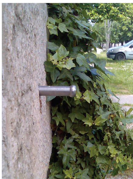
Slika 1-1 a i b. Kontrolni reperi na objektu
