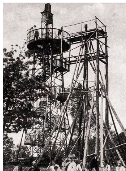
Slika 3. Konstrukcija na vidikovcu za postavljanje heliotropa i prva drvena geodetska piramida. Fotografija Serije I., broj 35.
