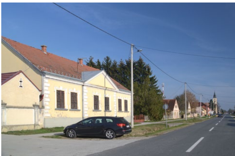
Slika 11. Zgrada nekadašnje šumarije Gola u ulici Stjepana Radića 22 (snimio: Z. Ištvan, 7.11.2018.).
