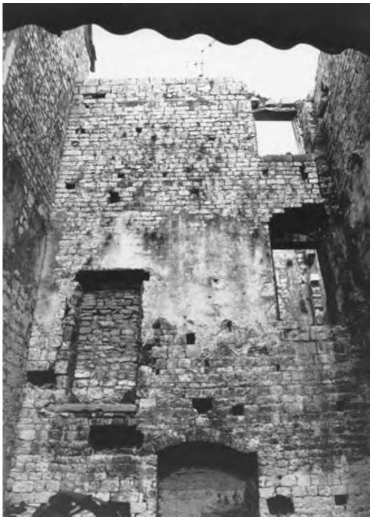
Sjeverni zid prostora 3a (foto: Ž. Bačić, Fototeka Konzervatorskog odjela u Splitu) Space 3a, northern wall
