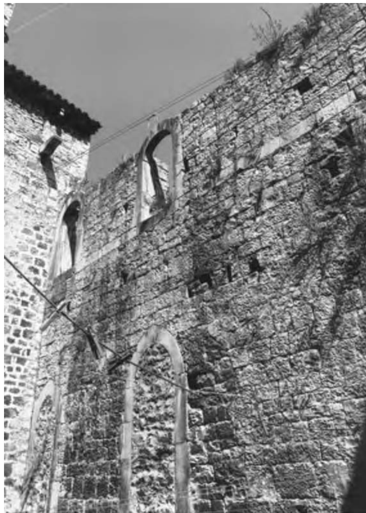
Zapadno dvorišno pročelje prostora 3a (foto: Ž. Bačić, Fototeka Konzervatorskog odjela u Splitu) Space 3a, western courtyard façade
