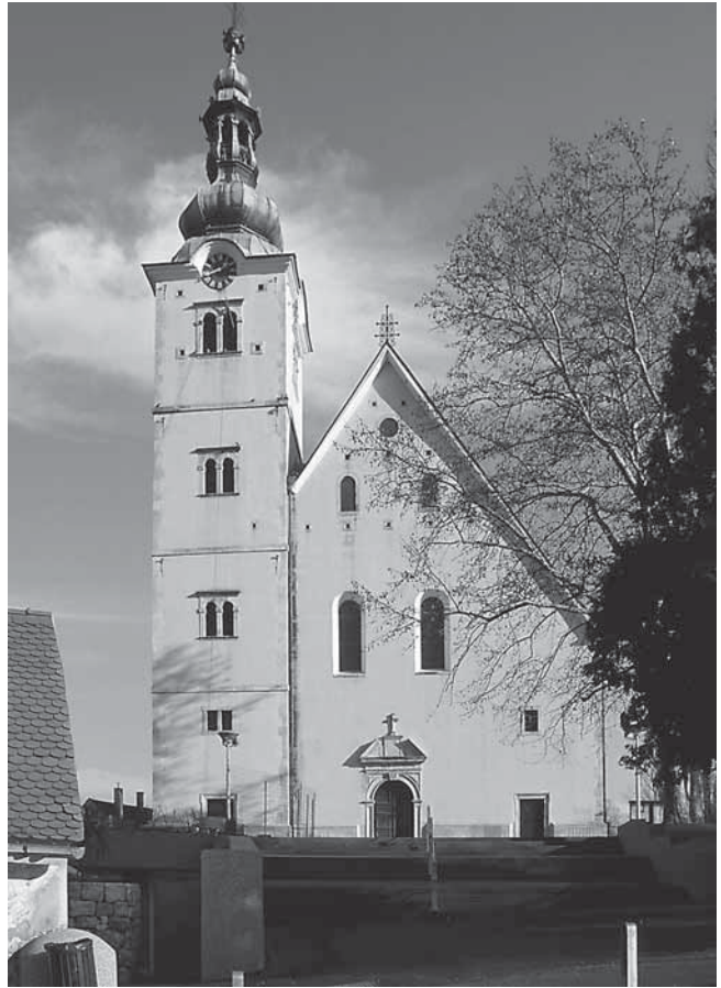
Župna crkva sv. Anastazije u Samoboru (1671.–1675.), pročelje (foto: M. Drmić) Parish church of St Anastasia in Samobor (1671–1675), façade
