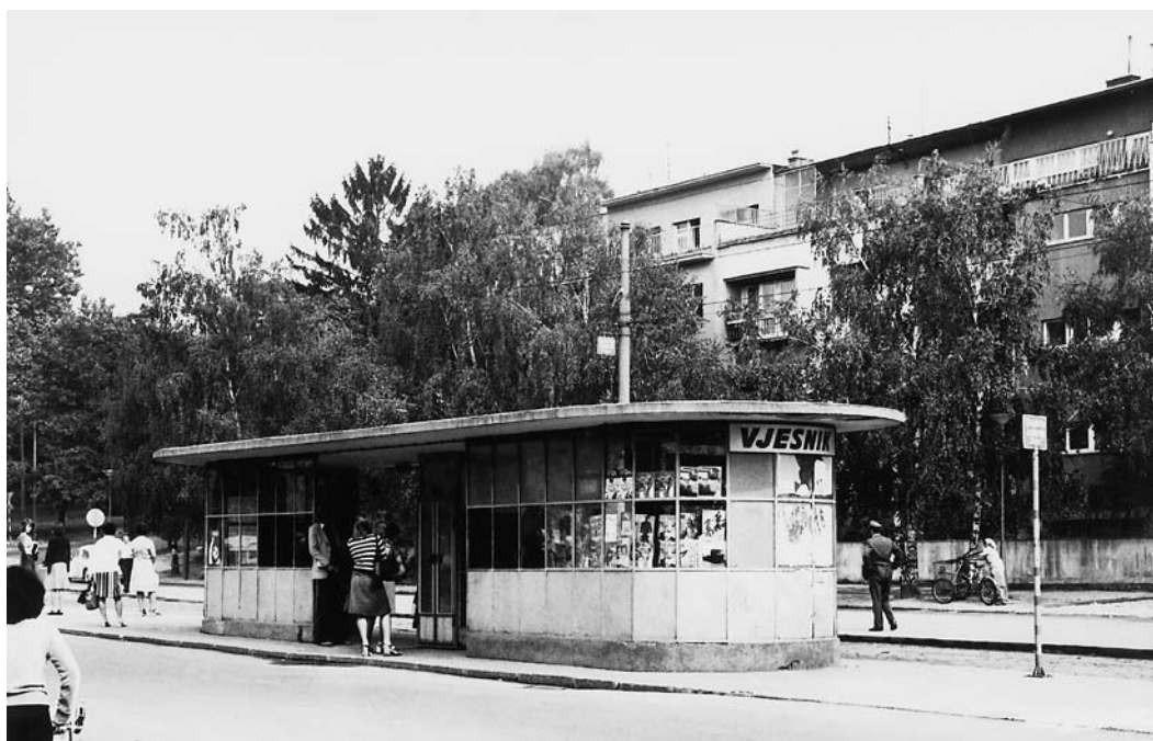
6. Tramvajsko stajalište na Gupčevoj zvijezdi, fotografija iz 1975. (foto arhiv ZET-a)
