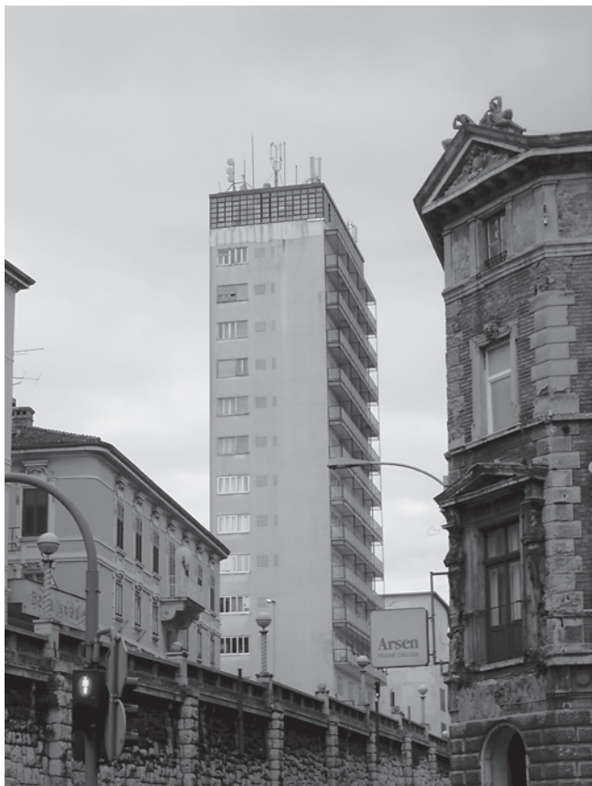
Pogled na zgradu Hrvatskog kulturnog doma iz središta Sušaka View from the centre of Sušak to the building of the Croatian Cultural Centre
